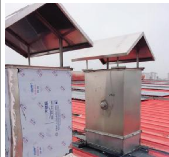
总装车间排气筒
