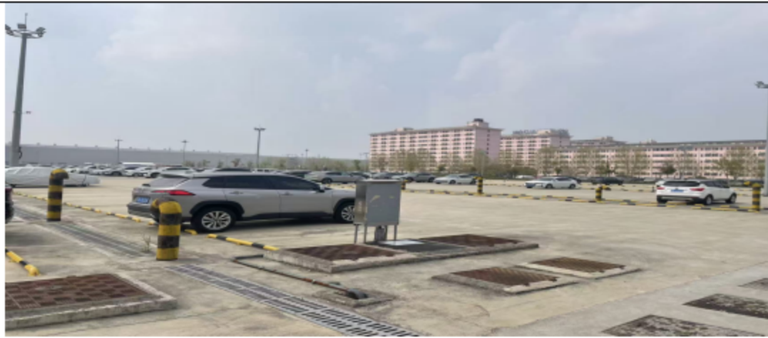
地下应急水池
